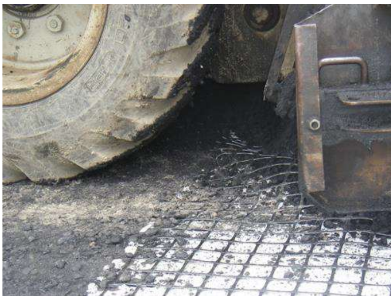
Рис. 3 Образование волны на георешётке из полипропилена при укладке асфальтобетона
