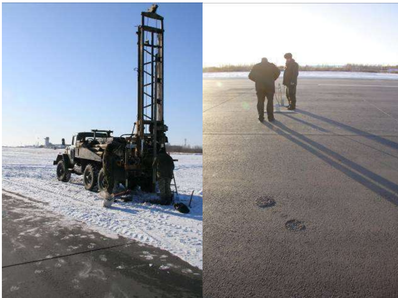
Рисунок 2. Выполнение буровых работ и следы скважин на ВПП. От георадара следов не остаётся.
