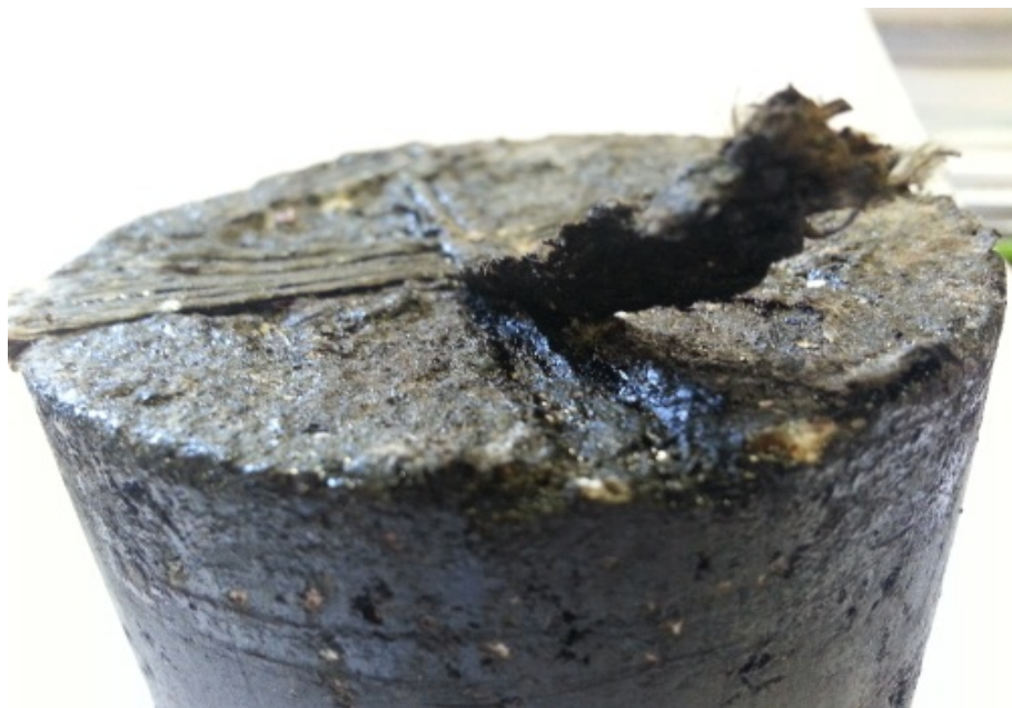
Рис. 3 Керн с геосеткой после извлечения из покрытия
