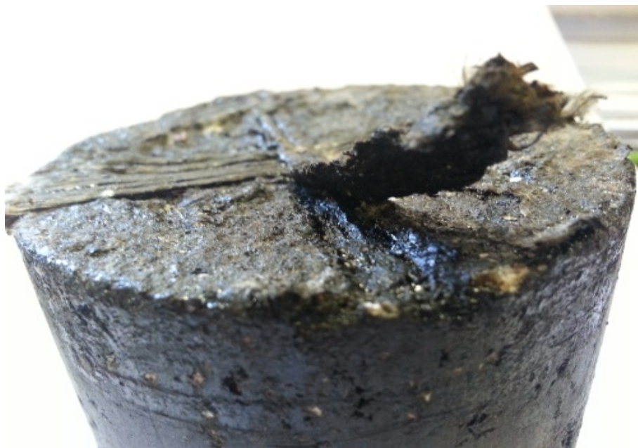
Рис. 3 Керн с геосеткой после извлечения из покрытия
